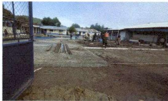
Foto 3. avanzando con la fundicion de patio con torta de concreto del establecimiento
