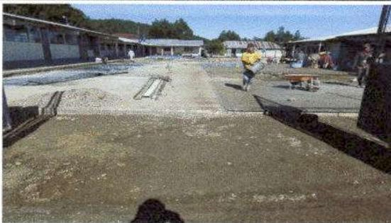
Foto 5. fundiendo piso de patio con torta de concreto del estacionamiento
